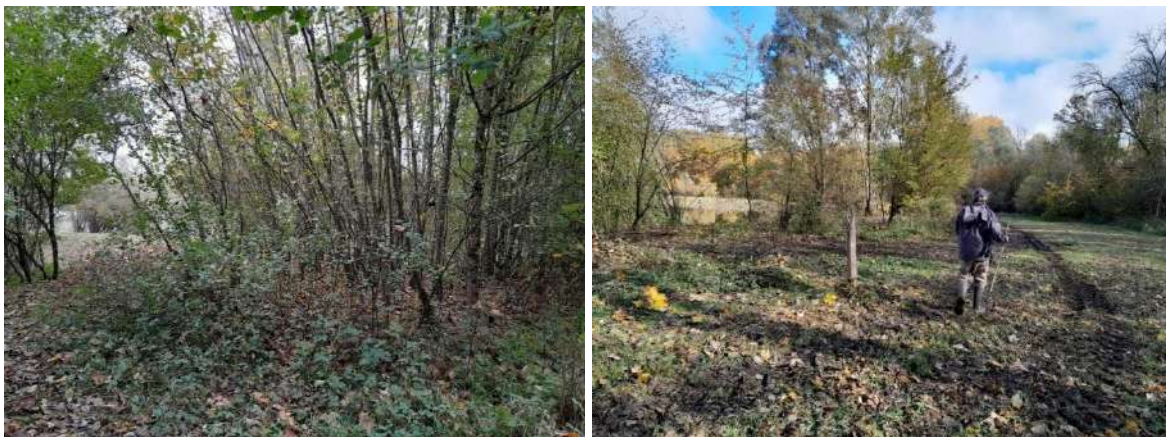
Figure 14 - Peuplement homogène d'érables sycomores au sud du plan d'eau avant (à gauche) et pendant (à droite) les travaux
